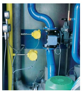
成功运作三年后,Qlear公司继续在其蒸汽回收系统中使用FCI公司ST98型质量流量计。ST98典型精度为1%读数,±0.5%满量程,重复性为0.5%读数。图中所示的2台流量计被用于测量供给发电的汽轮机的气流。其中一台测量的是回收的碳氢化合气流量,另外一台测量的是备用燃料气流量。
